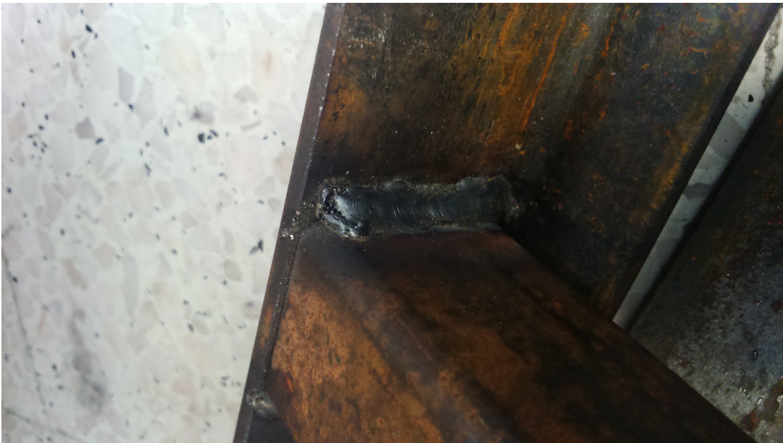
FIGURE 4.29.: Soudure au MIG
