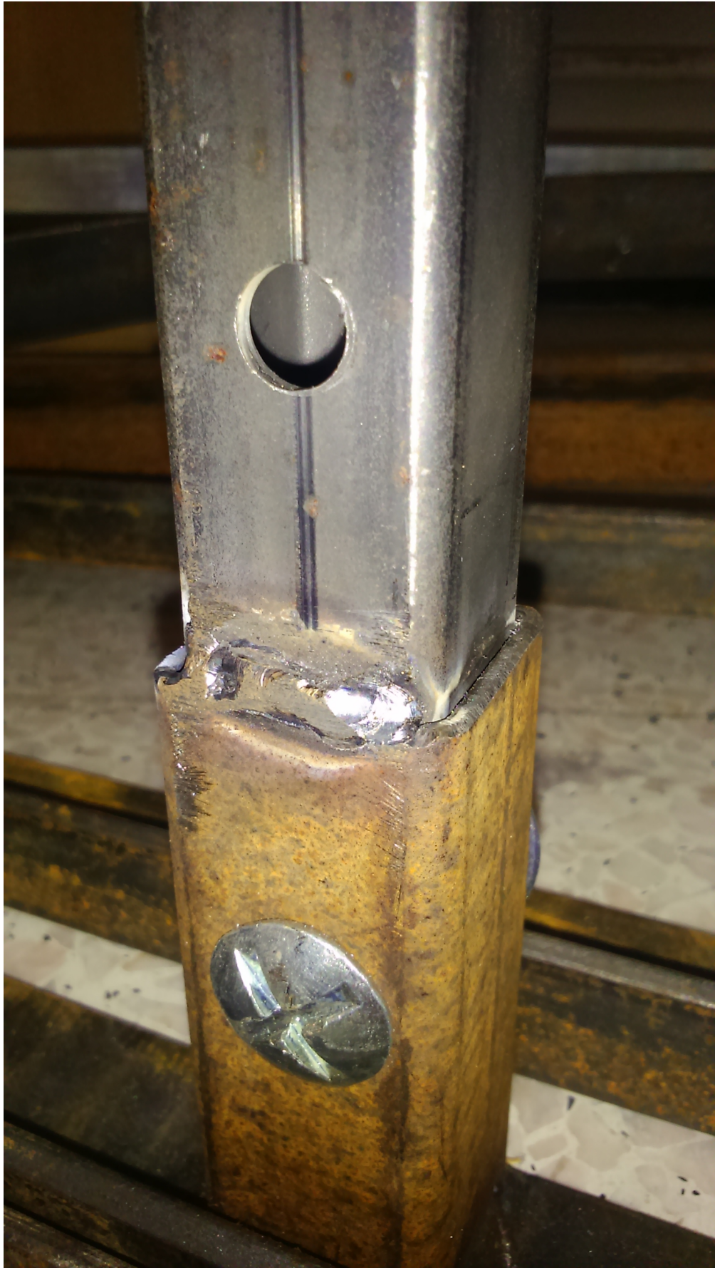
FIGURE 4.33.: Soudure à l'arc du support
